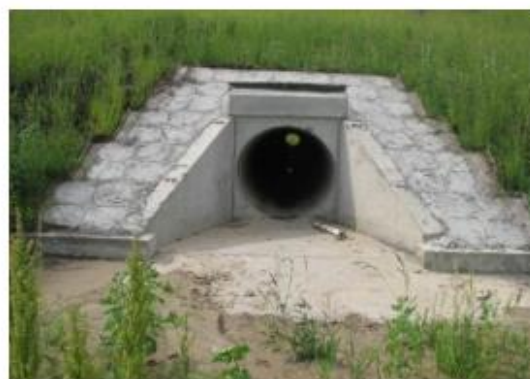
Рис. 10. Виды оголовков: порталный – справа, раструбный – слева
