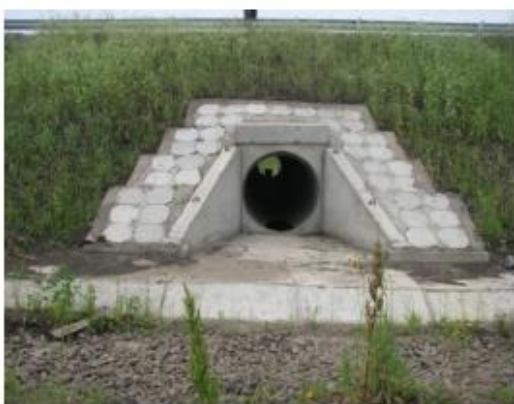
Рис.13 . Укрепление выходного русла комбинированного типа:
